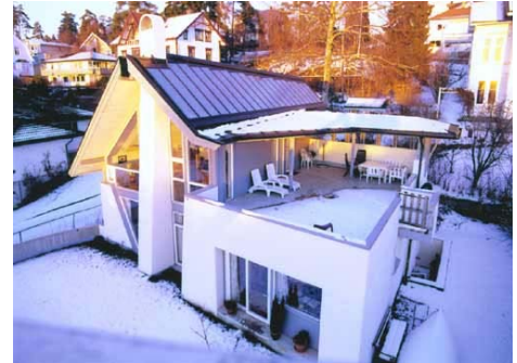
Solfangere på tak av privatbolig i Oslo
