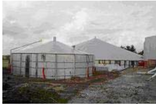
Gjøringstanker for husdyrgjødsel, Åna
