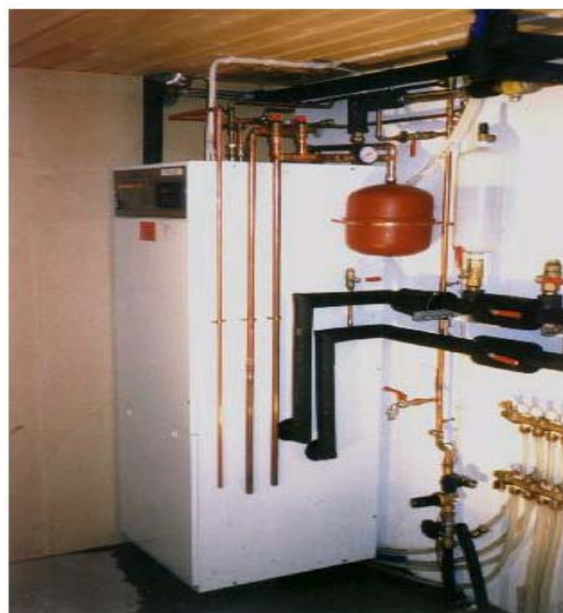
Vann-vann varmepumpe
