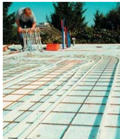
Legging av vannbåren gulvvarme
