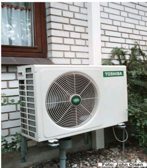
Uteluftbasert varmepumpe
