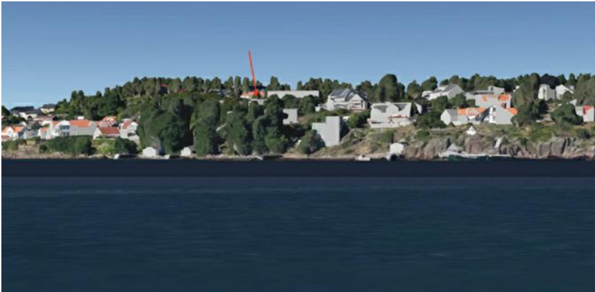
Bolig sett fra sjøen i øst. Ny bolig vises med pil.
