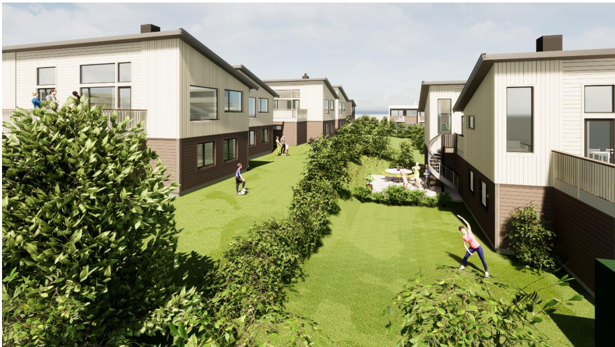
Terrassering av hageareal mellom boligrekkene
