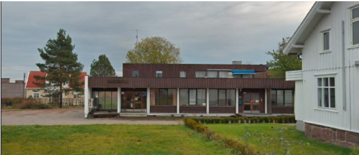
Eksisterende bygningsmasse innenfor BK sett fra Semsbyveien.
