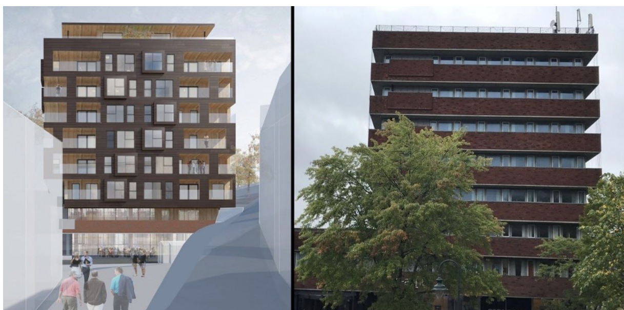
“Kremmerhuset”- bygningen slik den har stått siden 1971 til høyre, og med fasadeoppgradering ifb. med transformasjonen til nye leiligheter, til venstre.
