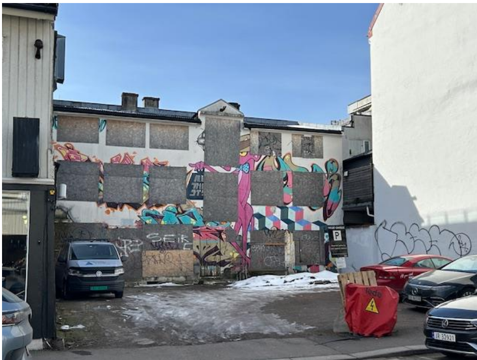
Dagens situasjon. Bakgårdsbygget forutsettes revet.
