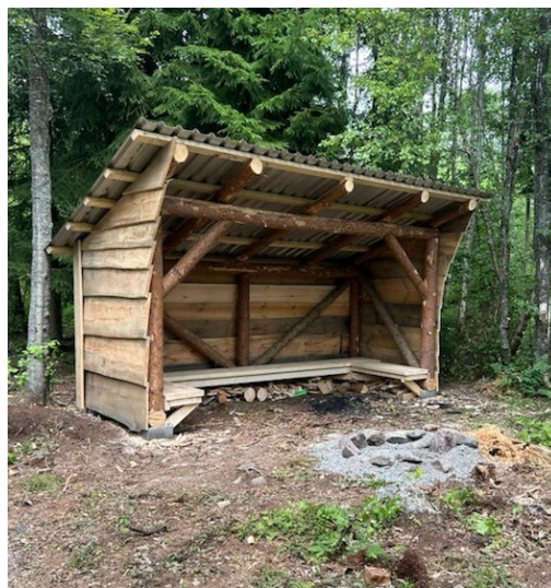
Figur 18 Gapahuk ferdig bygget
