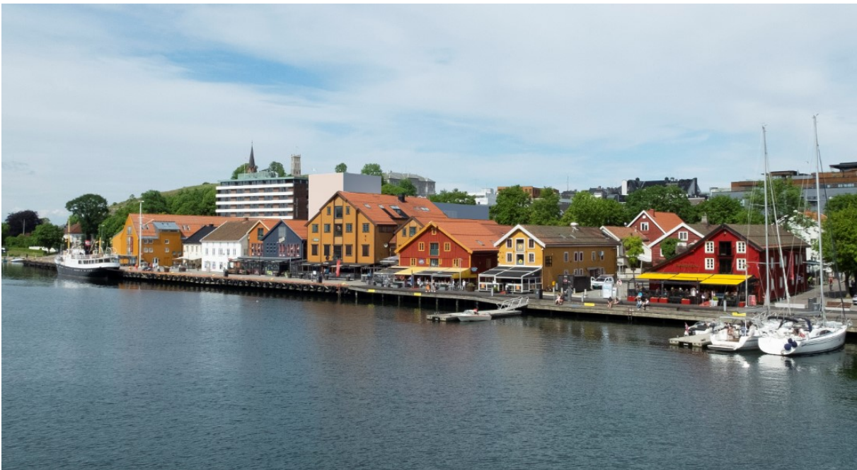
Figur 8 - eksisterende situasjon sett fra gangbroen. Med tillatt volum på Skibsgateplassen.
