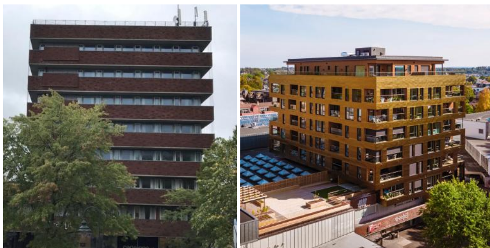
(T.v.) 'Kremmerhuset'- bygningen slik den har stått siden 1971, og med fasadeoppgradering ifb. med transformasjonen til nye leiligheter
