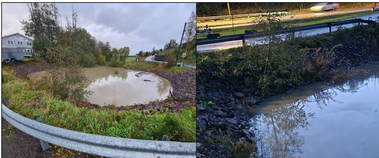
Figur 3. Revetalbekken ved innløpet til kulvert under Bispeveien 4. oktober 2025. Bilde til venstre: Tønsberg kommune. Bilde til høyre: NVE
