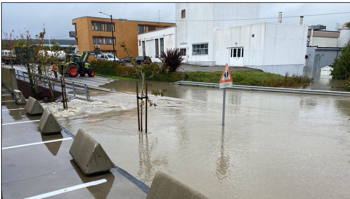
Figur 2. Flomvann inn mot Revetal sentrum som følge av overtopping av innløpet til sentrumskulverten under flommen i 2025. Bilde: Tønsberg kommune, 4. oktober 2025 klokken 15
