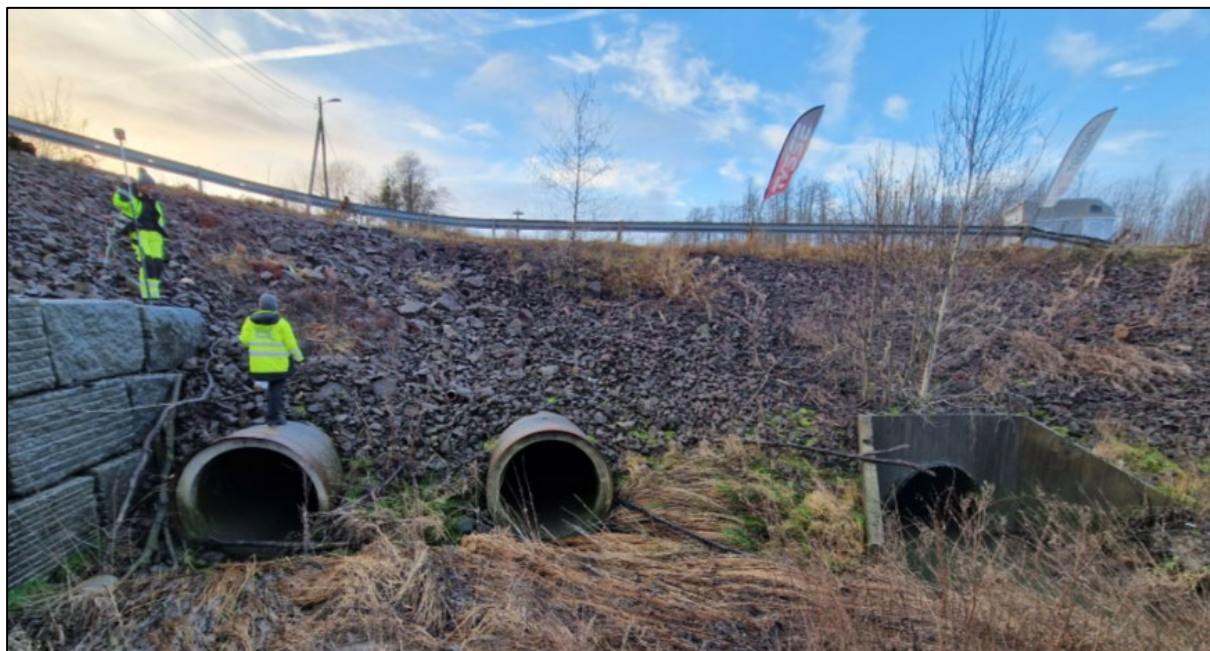
Figur 26. Innløp til kulvertene under Bispeveien. Innstikksrør med vingemur til vestre er koblet til gammel steinkiste. Bilde tatt under befaring 15.12.2025 (NVE)
