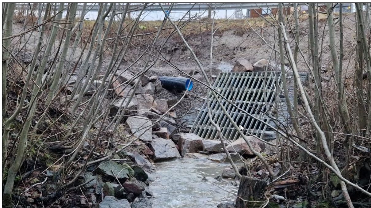
Figur 25. Innløpskonstruksjon med rist, Sentrumskulvert
