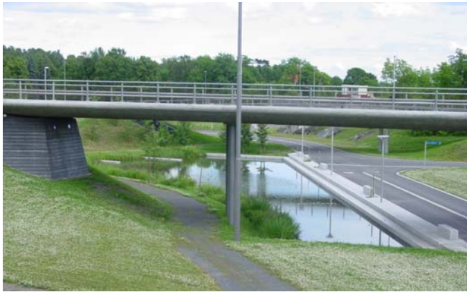
Vått basseng for overvann fra veianlegg som kombinerer rensing, fordrøyning og god landskapstilpasning (Fornebu, foto: COWI)
