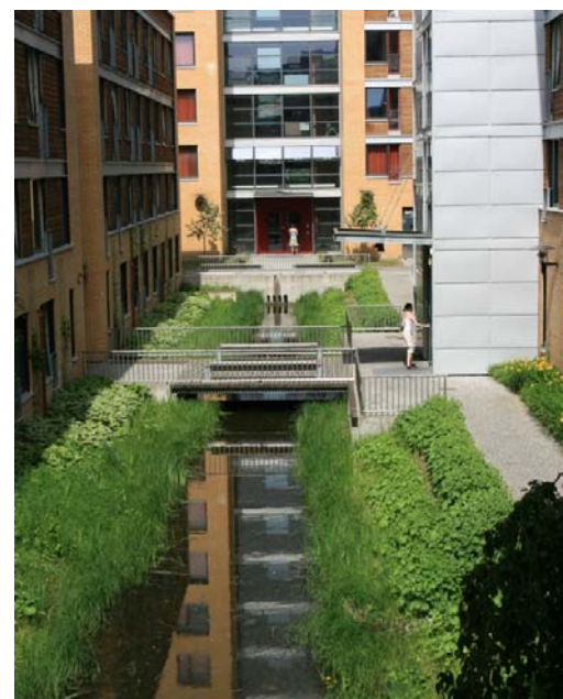
Vått basseng i gårdsrom for fordryning av takvann, Bjølsen Oslo (foto: Rainer Stange)
