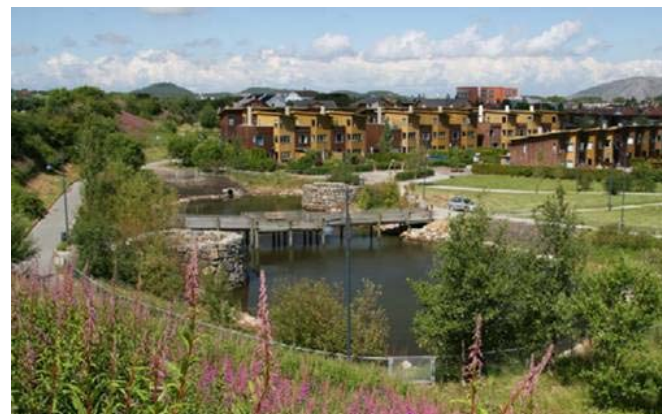
Åpen overvannsdam i Smeaheia i Sandnes (foto: Sandnes kommune)
