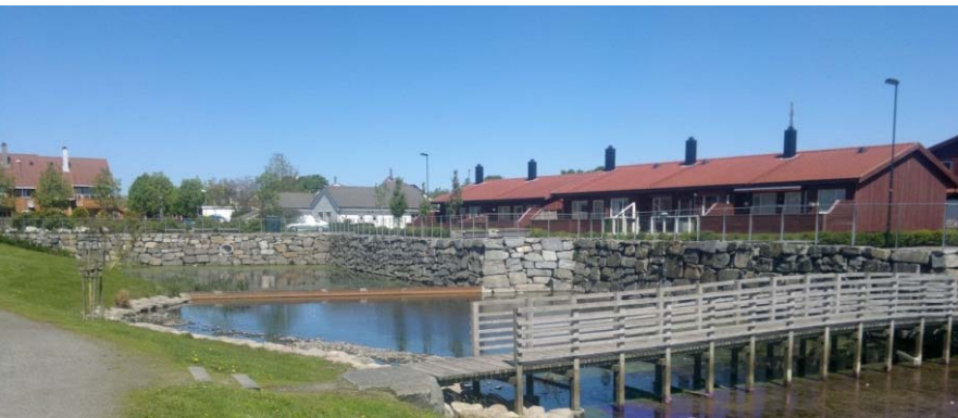
Fordrøyingsbasseng Kleppestemmen i Klepp (foto: Frank Bjørnø).
