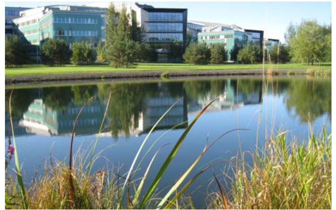
Vått basseng for takvann fra næringbygg (kontorer) med meget god vannkvalitet (Fornebu, foto: COWI).
