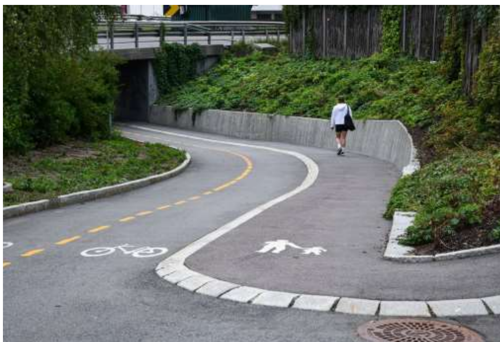
Figur 6-6: Sykkelvei med fortau. Denne løsningen er valgt som hovedløsning for sykkel og gange langs alle hovedaksene, med noen unntak (foto: Knut Opeide, Statens vegvesen).
