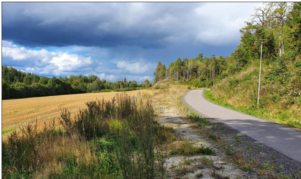
Figur 15 Bøløkene sett fra gs-veg mot nord. Tydelige randsoner med vegetasjon og koller omkring svakt hellende dyrkemark ned mot Lefsrødbekken (Norconsult)
