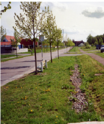
Figur 7 Åpen fordrøynings- og infiltrasjonsgrøft i boligområde
