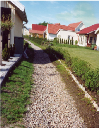
Figur 6 Steinfylt infiltrasjonsgrøft i boligområde
