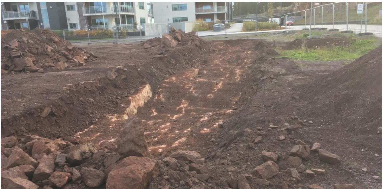
Figur 8: Graving delområde 2 – sett mot syd
