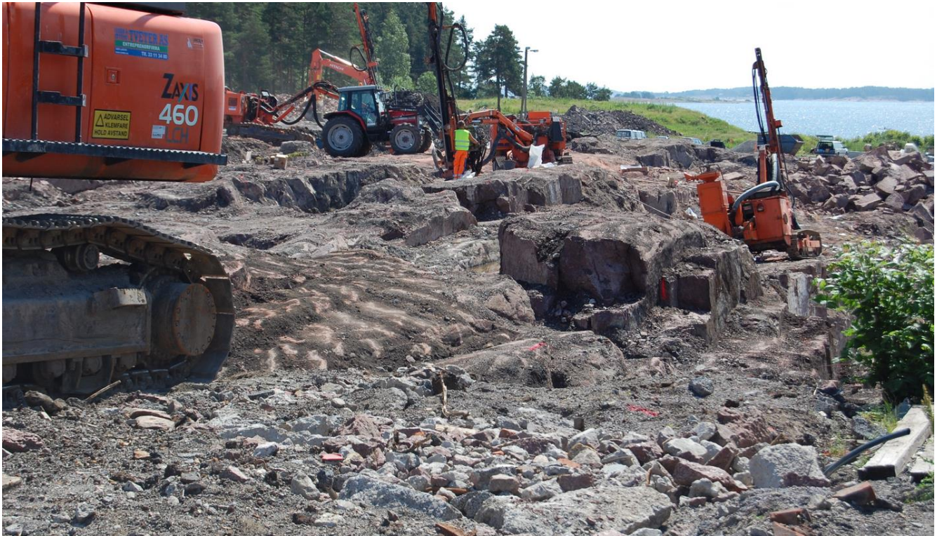
Figur 7: Sprengningsarbeider vestre del av øya – sett mot syd
