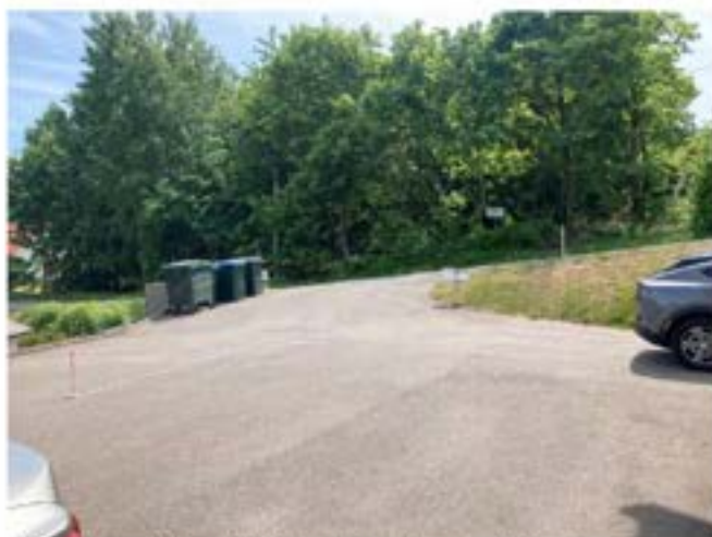
Innkjørsel Peer Gynts vei 2A/B før og etter omlegging av bakken
