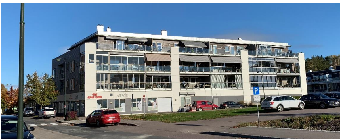
Fig 23. Revetalgata 44 (Revetal Park 2) sett fra sørvest
