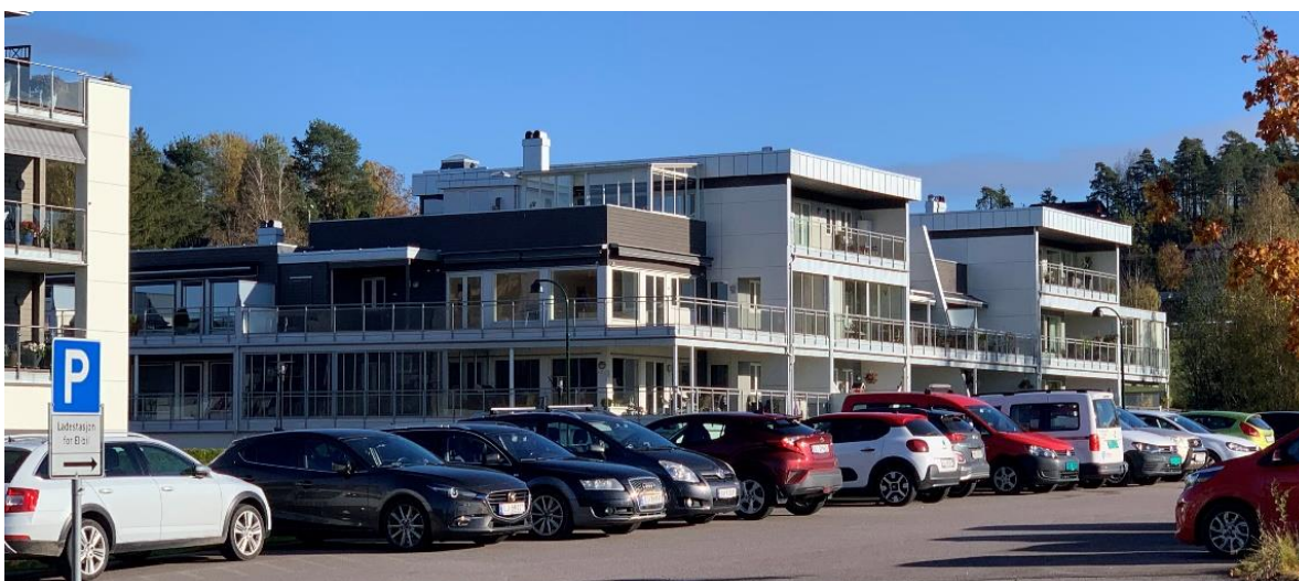
Fig 24. Revetalgata 32 (Revetal Park 2) sett fra sørvest
