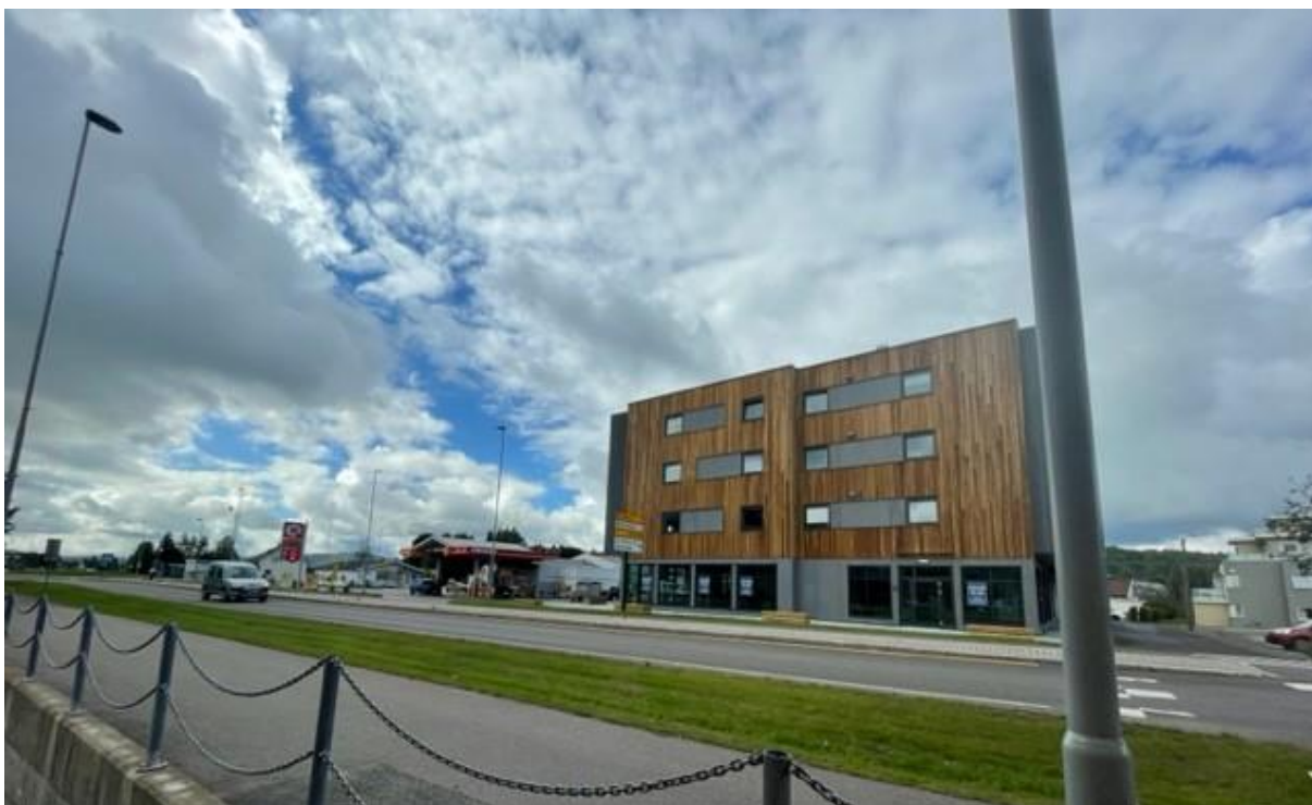
Fig 25. Gamleveien 6, bilde fra øst.
