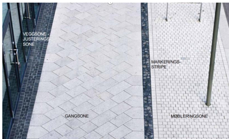
Eksempel på soneinndeling i gate med veggzone, gangzone og møbleringszone. Kilde: Arkitektoniske virkemidler for orientering og veifinning
