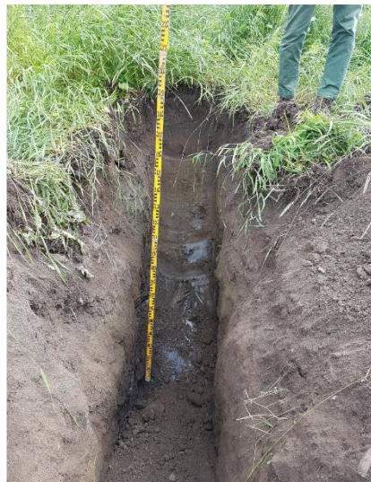
Figur 3: Bilder. Venstre - graving av prøvehull for etablering av overflateinfiltrasjon, høyre - sjaktning av prøvehull
