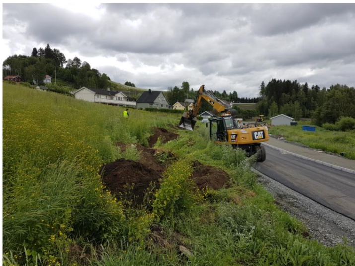
Figur 3: Bilder. Venstre - graving av prøvehull for etablering av overflateinfiltrasjon, høyre - sjaktning av prøvehull
