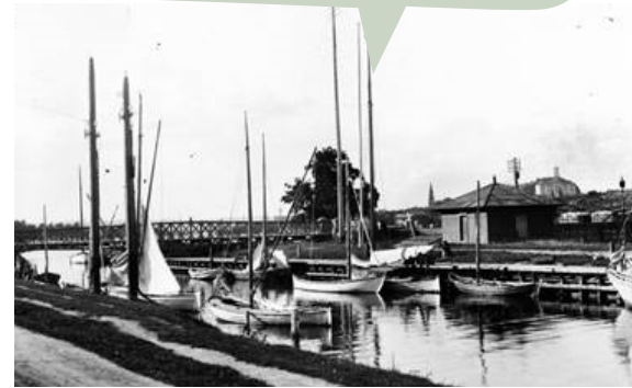
Den gamle kanalbrua. Foto: Slottsfjellmuseet
