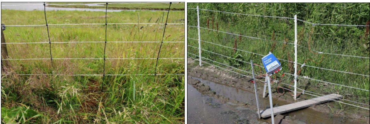
FIGUR 16. GJERDER MELLOM LANDBRUKSAREAL OG UTMARKSAREAL MOT SJØ. BILDET TIL VENSTRE VISER NETTINGGJERDE OG BILDET TIL HØYRE VISER STRØMGJERDE, BEGGE GJERDETYPER HAR VÆRT UTPRØVD OG HAR EFFEKT. (FOTO: GØRLI ELIDA BRUUN ANDERSEN ©).
