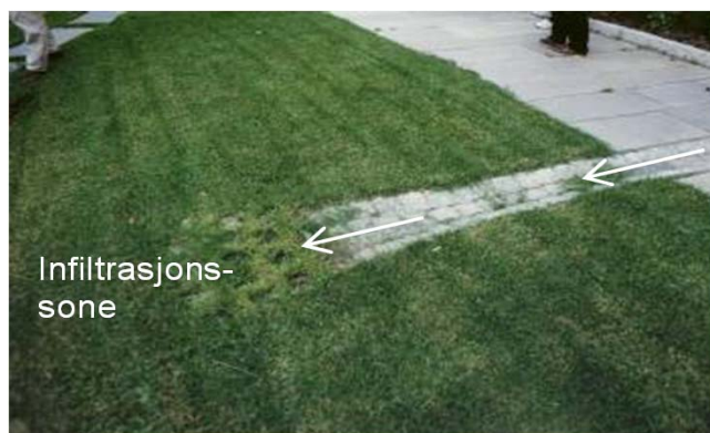
Infiltrasjon av takvann på plen (foto: COWI)
