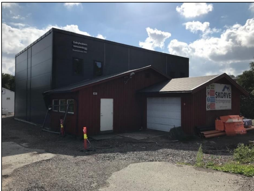
Bilde: Nye Søbyholmen renseanlegg.
