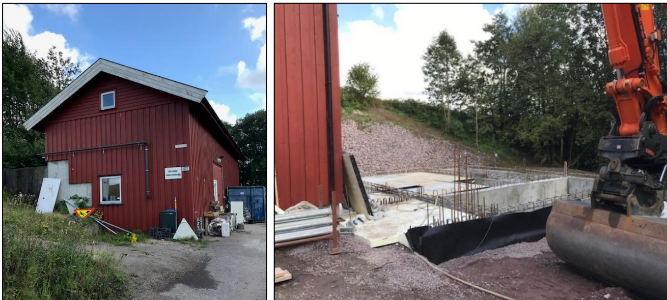
Bilde: Undrumsdal renseanlegg er under ombygging/utvidelse august 2021.
