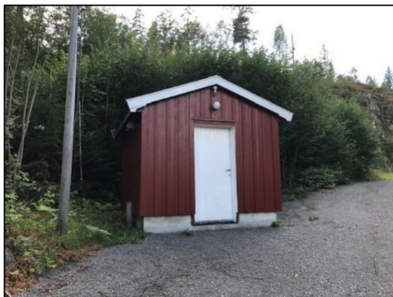
Bilde: Vivestad vannverk grunnvannsbrønn.
