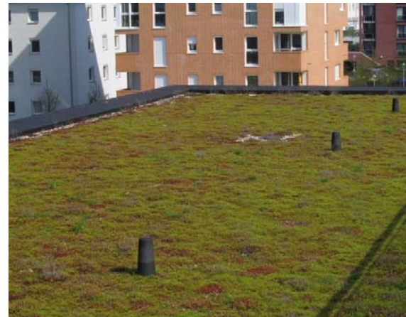
Grønt tak (Scharnhäuser Park, Stuttgart, foto: COWI).
