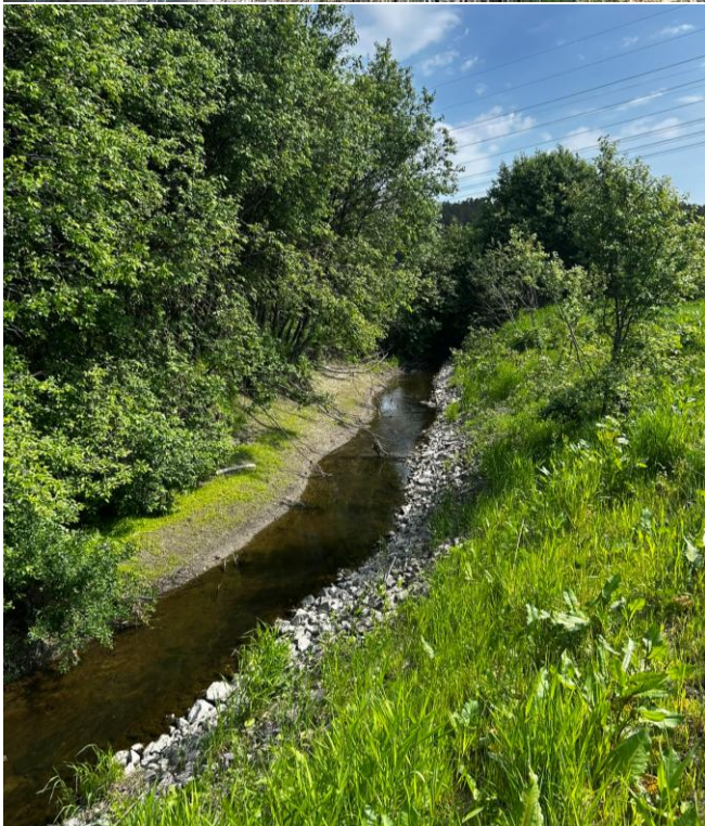
Figur 6. Naturbasert erosjonssikring med revegetert steinsetting i Rastadelta, før og etter gjennomføring. Fotograf: Miguel A. Segarra Valls.
