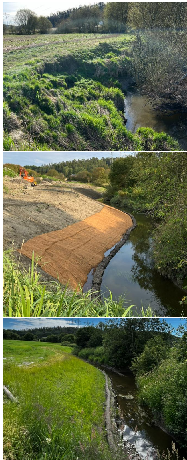
Figur 5. Naturbasert erosjonssikring med reprofiling, kokosmatter og steinruller i Rastadelva, før, under og etter gjennomføring. Fotograf: Miguel A. Segarra Valls.
