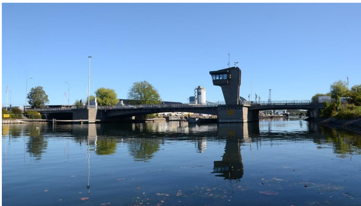
Figur 4-7. Bro sett fra ubåtstasjon mot øst.
