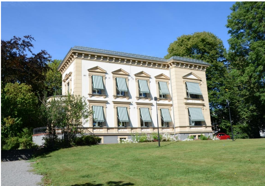
Figur 4-9. Hovedbygning, Svend Foyns gate 3.
