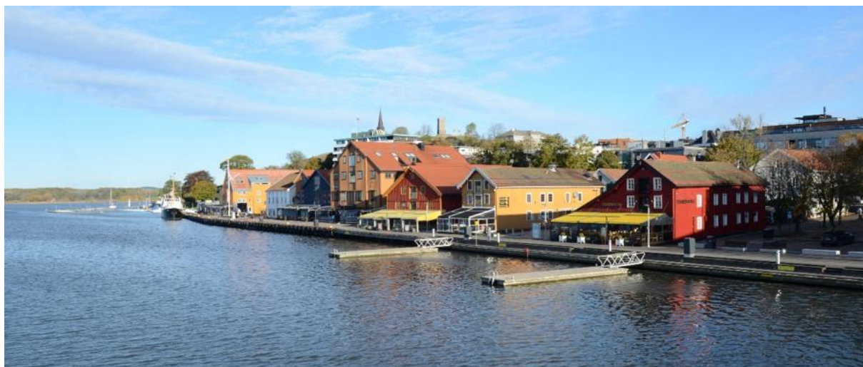
Figur 4-17. Nedre Langgate 26 – 38 sett fra Bybroen mot nord.
