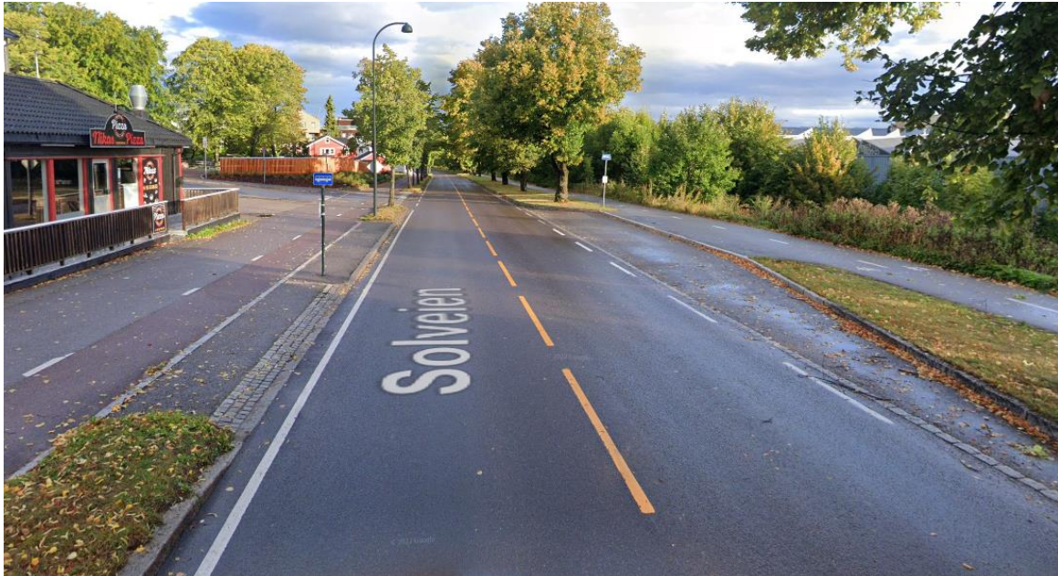
Figur 2-6 Kaldnes Hasselveien bussholdeplass mot nordvest
