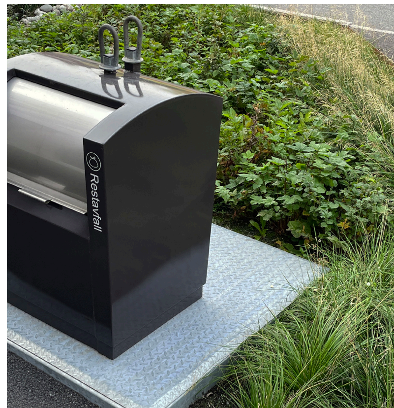
Nedgravde containere innarbeidet i frodige bed
