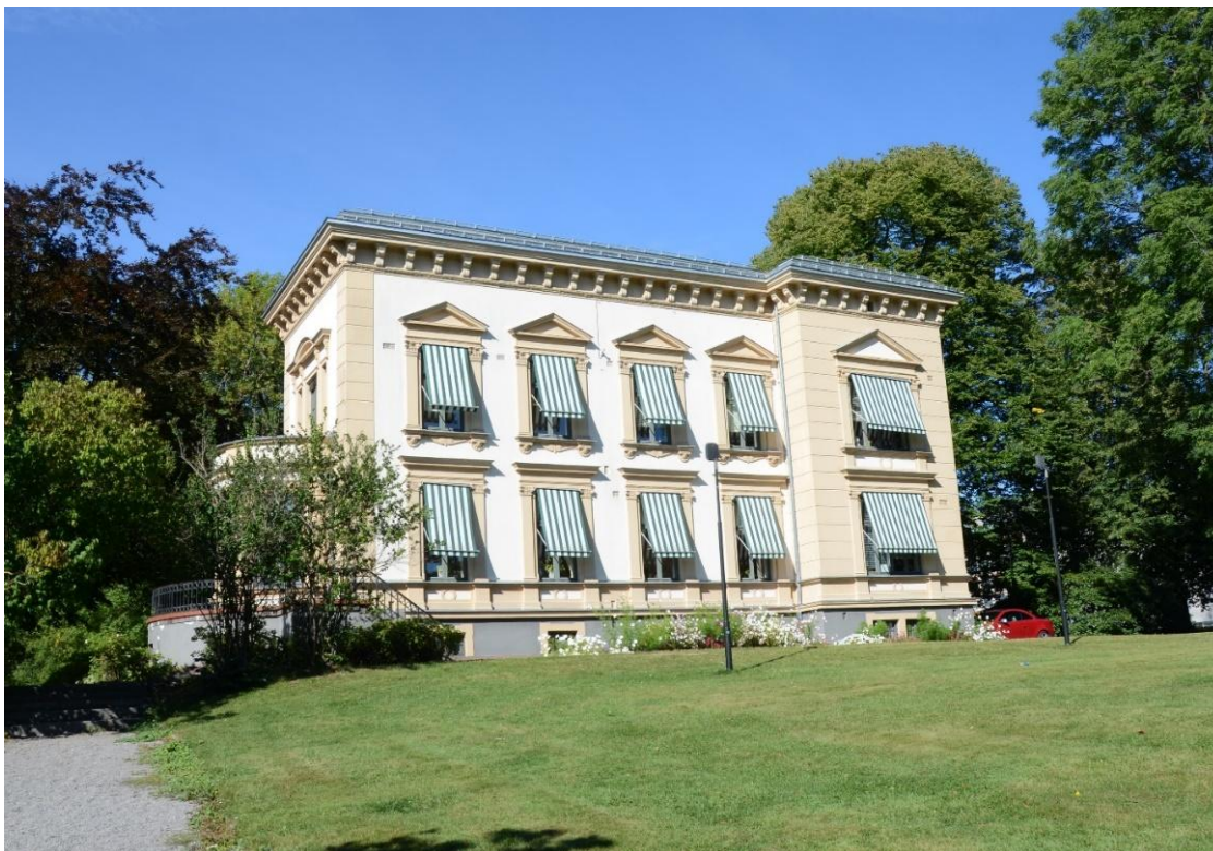
Figur 4-9. Hovedbygning, Svend Foyns gate 3.
