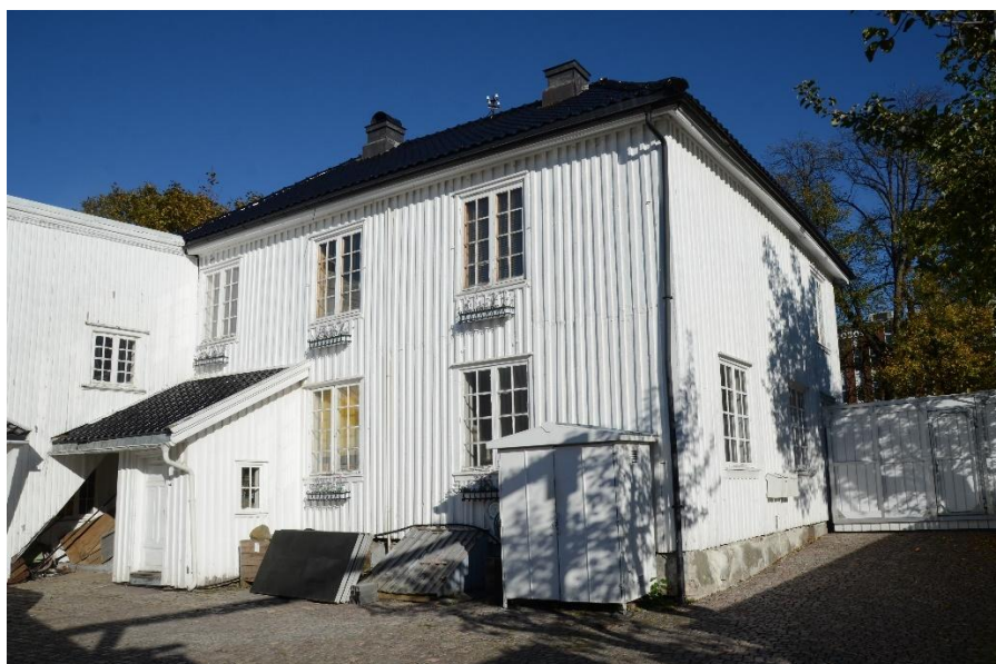
Figur 3-5. Foynegården Bolig. ID 86614-1, oppført ca. 1750 eller 1800-50. Nedre Langgate 18D.
