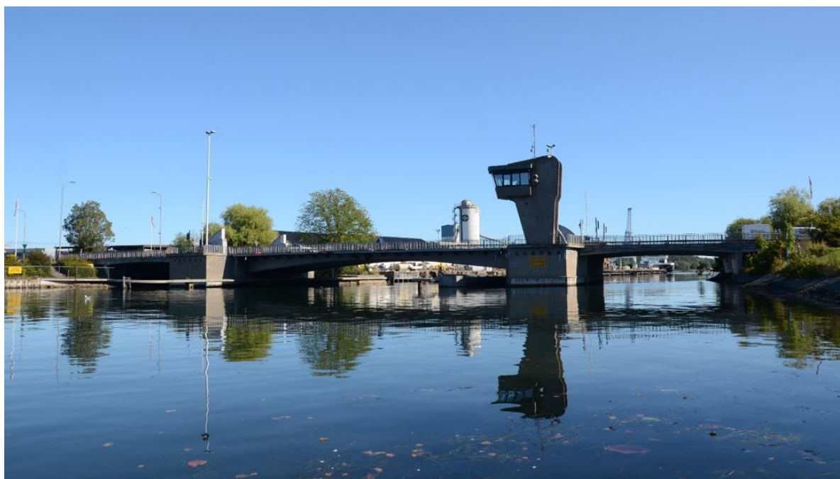
Figur 4-7. Bro sett fra ubåtstasjon mot øst.
