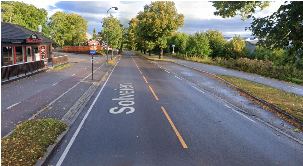
Figur 2-6 Kaldnes Hasselveien bussholdeplass mot nordvest
