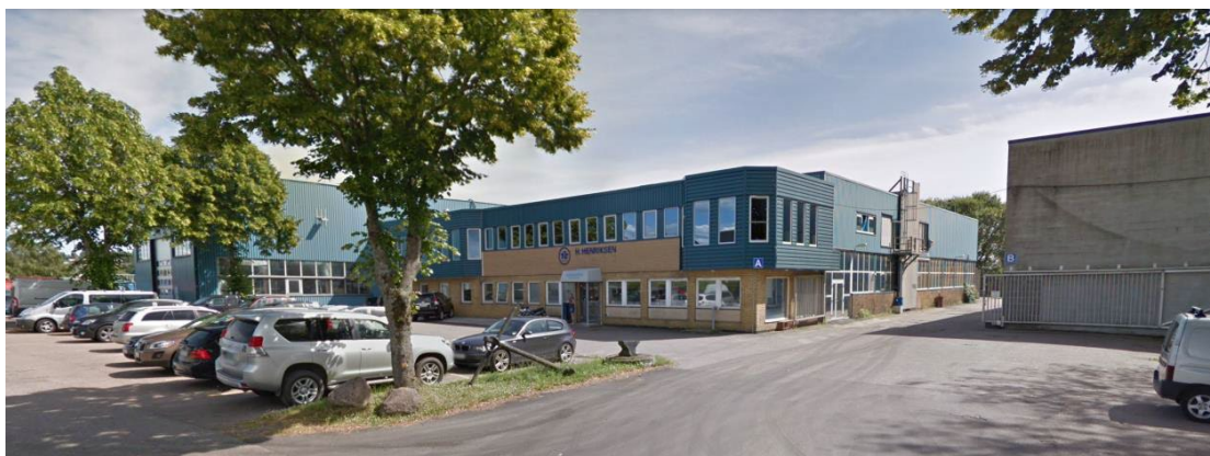
Eksisterende bebyggelse (bilde hentet fra Google Street View).
