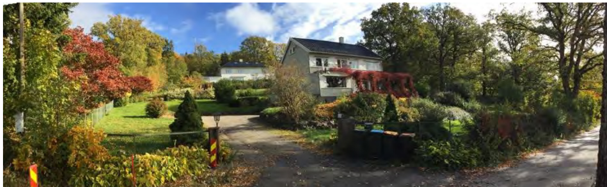
Figur 3 Kjellengveien 7 – planområdet med eksisterende bolig. (foto: google street view)
